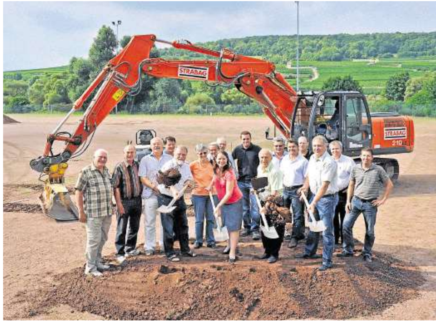
Mit dem obligatorischen Ersten Spatenstich haben gestern Vormittag die Bauarbeiten am Großwinternheimer Sportplatz begonnen. Der Tennenbelag wird durch Kunstrasen ersetzt.
